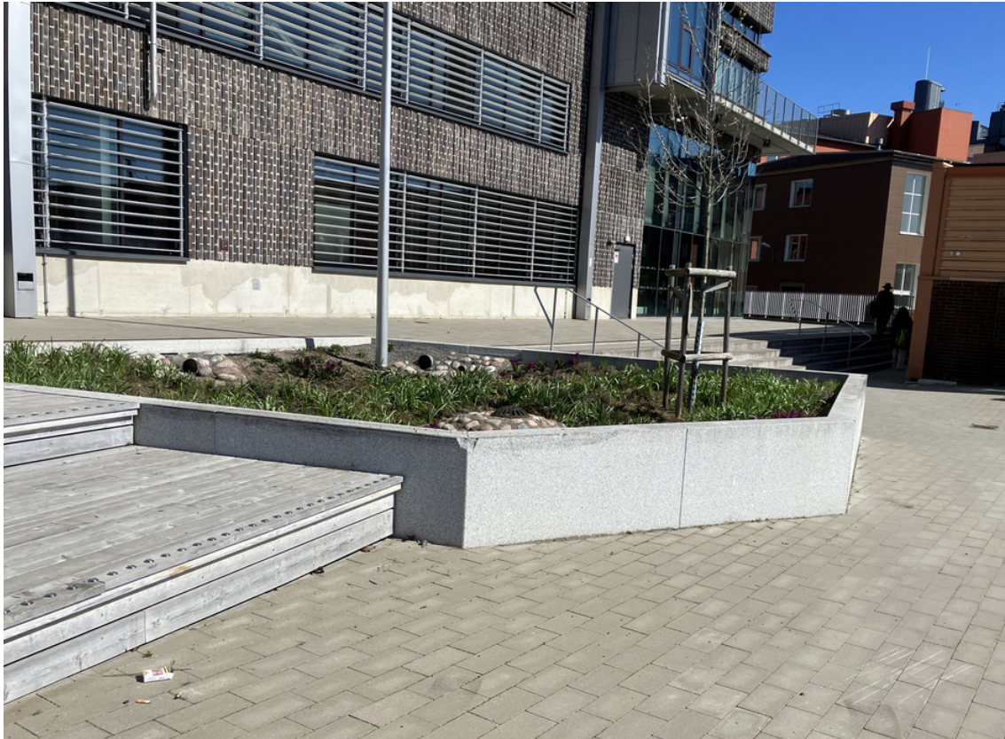
Figur 7: exempel på ett litet dagvattenmagasin i bebyggd miljö. Observera inloppsledningarna vid magasinets borte överkant samt den upphöjda kupolbrunnen nära bildens mitt
